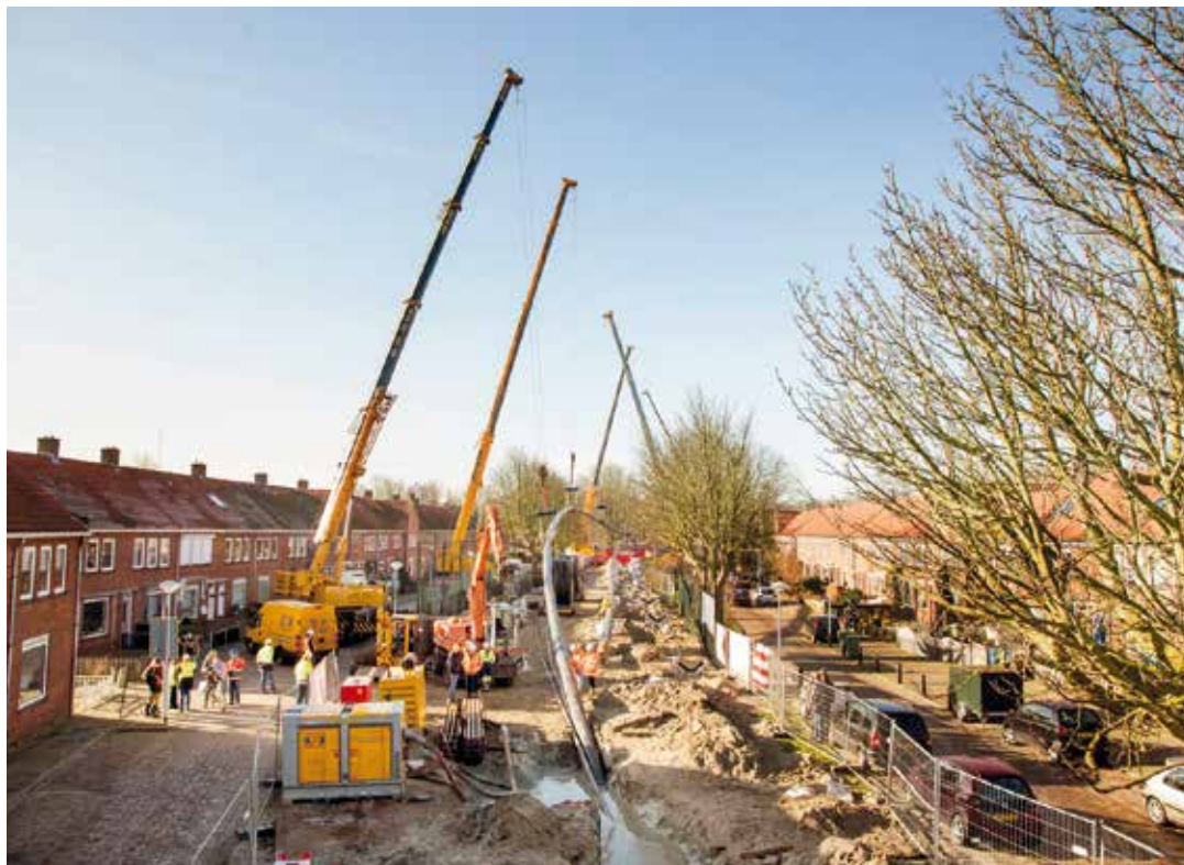
Werkzaamheden aanleg Warmtenet Alkmaar, HVC.
